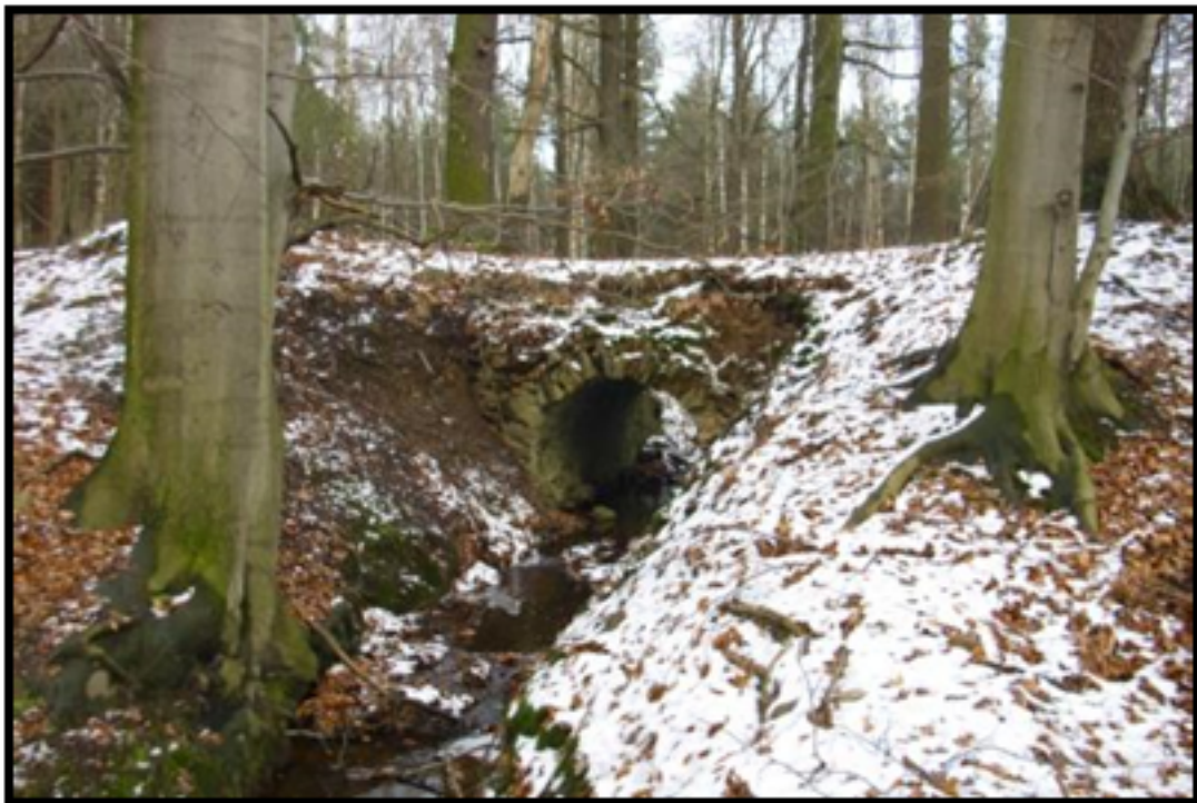
Tatsächlich erscheint die Bogensteinbrücke im Vergleich zur Elligast relativ mächtig. Schade das dieses Bächlein heutzutage relativ wenig Wasser führt, denn so kann nicht einmal ein Schlammpeitzger im Bach überleben.
